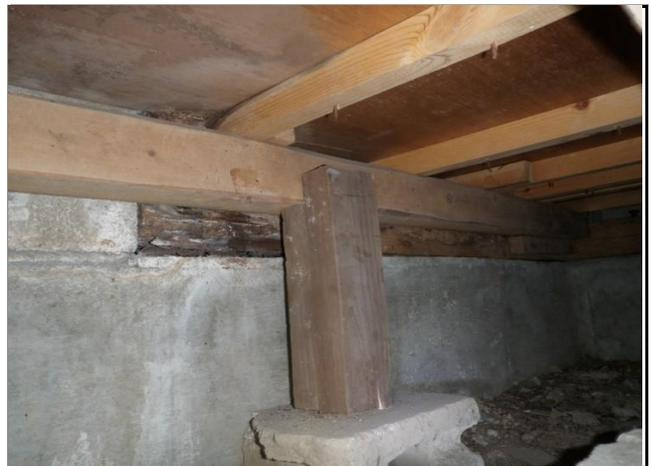
写真4. 浴室部（土台に腐朽の形跡有）
